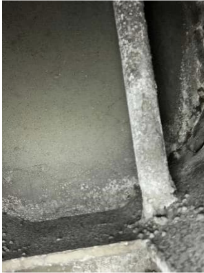
Abbildung 70: Verzinkung innen Mastkopf mit Weißrost / Zinkkorrosion
