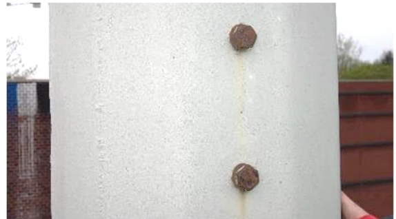
Abbildung 42: Schrauben korrodiert
