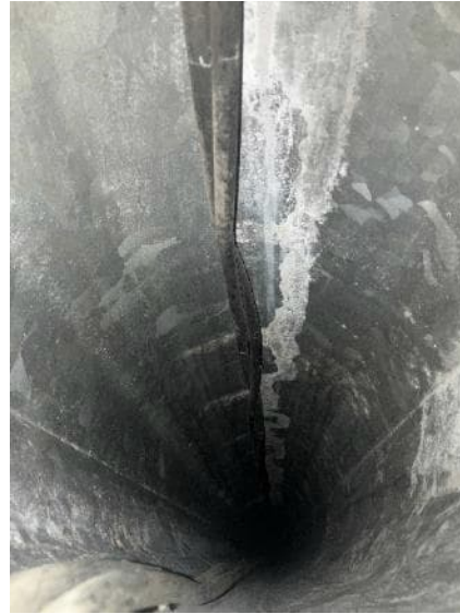
Abbildung 71: Verzinkung innen (ab Mastkopf nach unten) intakt, Ablagerungen erkennbar
