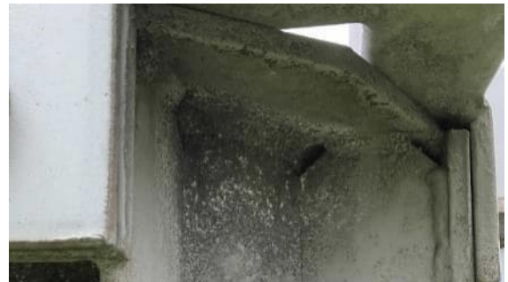
Abbildung 44: Weißrost / Zinkkorrosion am Mastkopf
