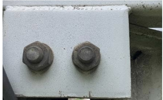
Abbildung 47: Korrodierte Schrauben an Verbindungsflansch zum Mast
