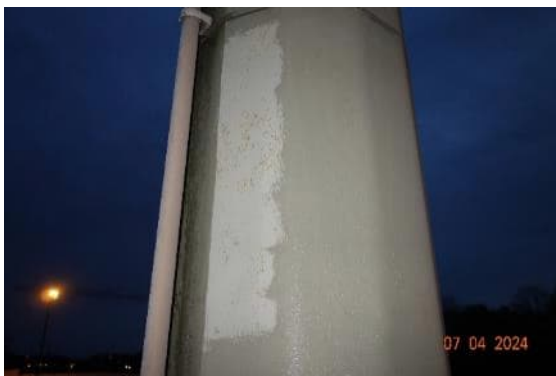
Abbildung 87: Fehlstelle in der Beschichtung
