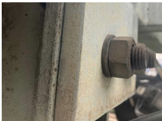
Abbildung 22: Korrosion an den Schraubverbindungen, keine Korrosion an Stahlbauteilen
