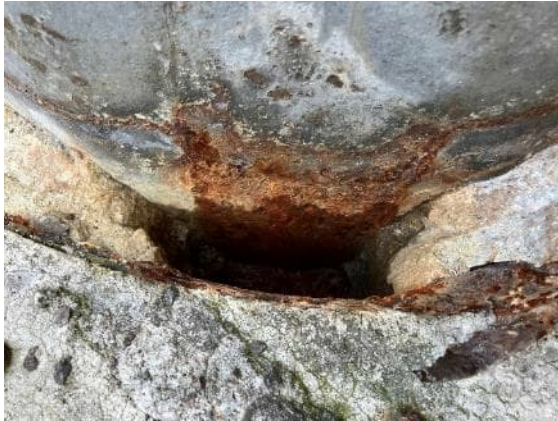
Abbildung 58: deutliche Korrosionsspuren im Bereich eines ausgestemten Holzkeils Mast 1
