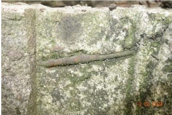
Abbildung 54: freiliegende korrodierte Bewehrung
