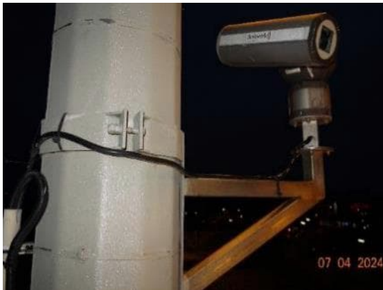
Abbildung 93: CrNi-Stahlkonsole zur Kamerabefestigung
