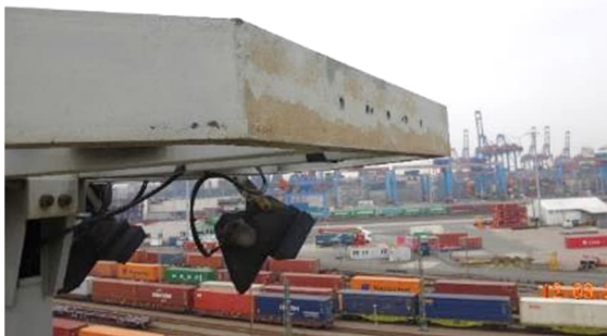
Abbildung 20: Abrasion der Beschichtung, keine Korrosion festgestellt
