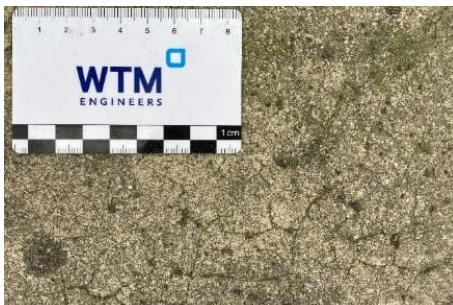
Abbildung 33: Netzartige Rissbildung Fundament (Vergussbeton Masteinbindung) Mast 4A
