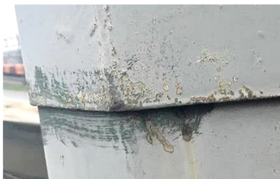
Abbildung 13: Schäden an der Beschichtung, keine Korrosion am Substrat erkennbar
