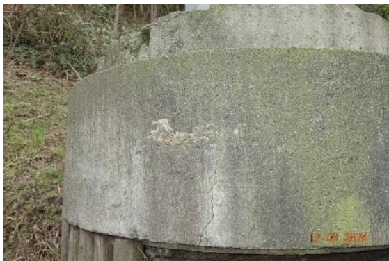
Abbildung 56: Schachtring vertikal gerissen
