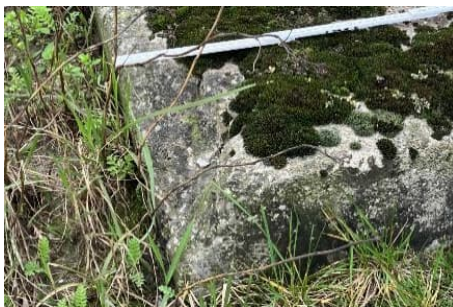
Abbildung 31: Abplatzungen und Bewuchs an Betonfundament Mast 4A
