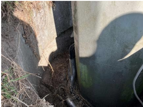
Abbildung 103: Hangabstützung mit Schachtringen Mast 4
