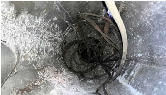
Abbildung 45: Korrosionsspuren an Mastinnenseite
