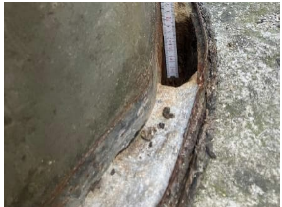
Abbildung 61: freigelegte Masteinbindung mit korrodiert Oberkante der verlorenen Schalung Mast 1
