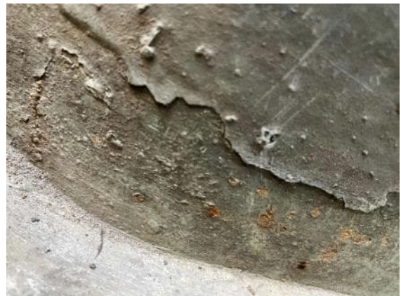
Abbildung 106: Ablösung der Beschichtung und Korrosionsspuren Mast 4
