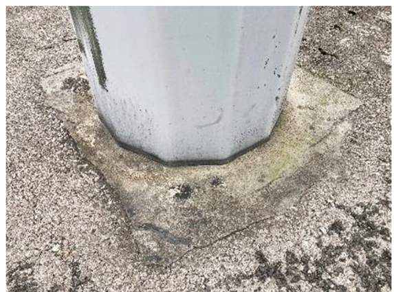
Abbildung 28: Einbindung Mast 4A in Fundament
