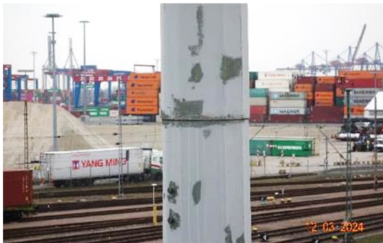
Abbildung 6: Ausbesserungen der Beschichtung - über ganze Mastlänge feststellbar
