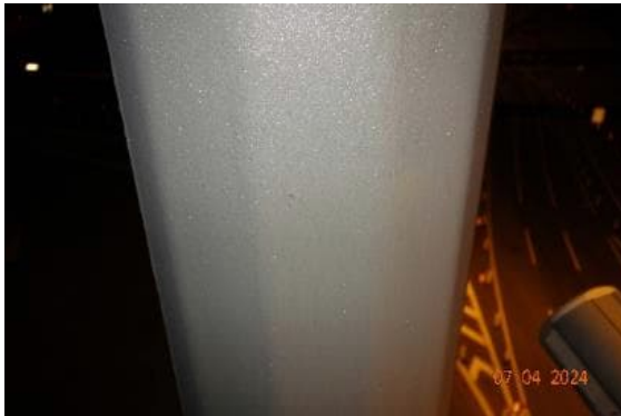
Abbildung 83: Beschichtung in insgesamt gutem Zustand
