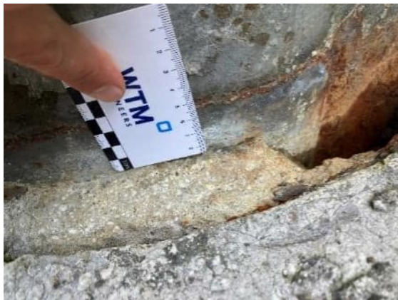
Abbildung 60: Korrosionsspuren an ehemalige Oberkante Vergussbeton Mast 1
