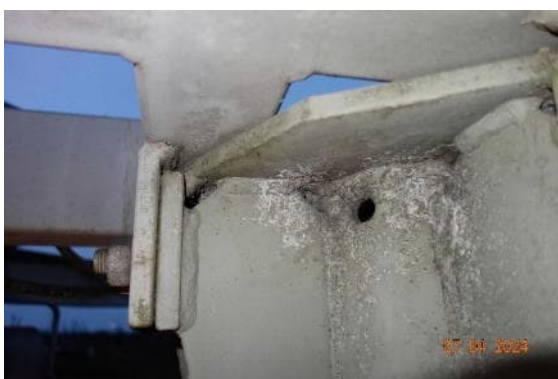
Abbildung 68: Mastkopf mit Weißrost / Zinkkorrosion
