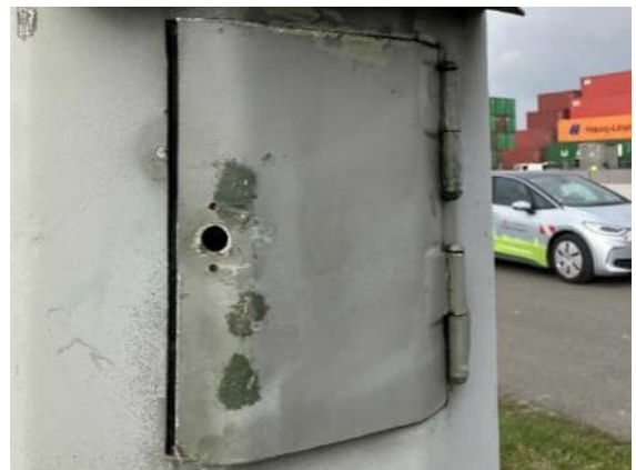
Abbildung 17: Revisionsklappe beschädigt
