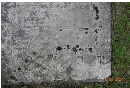
Abbildung 29: sich abzeichnende Bewehrung Fundament Mast 4A
