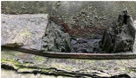
Abbildung 43: Korrosionsspuren am Mastfuß im Übergang zum Betonfundament
