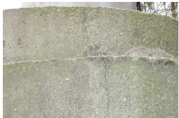
Abbildung 57: Schachtring vertikal gerissen
