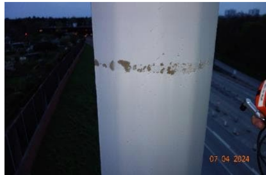
Abbildung 65: Abplatzungen der Beschichtung mit Korrosionsspuren im Bereich ehemals angebrachter Blehbänder o.Ä.
