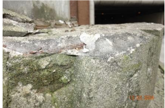
Abbildung 55: freiliegende korrodierte Bewehrung und mit Betonabplatzungen
