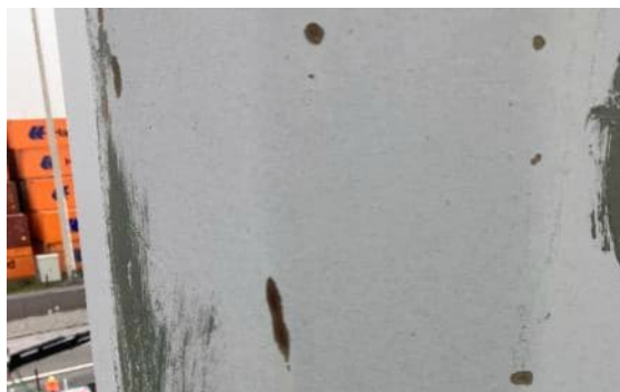
Abbildung 11: Abplatzungen an der Beschichtung und der darunterliegenden Verzinkung mit leichten Korrosionsspuren
