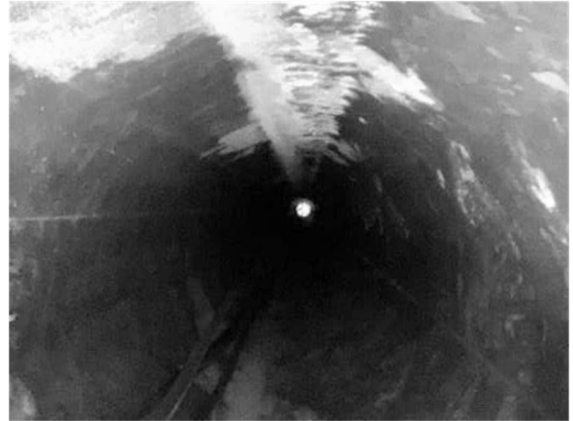
Abbildung 15:: Verzinkung innen (ab 1,5 m Höhe nach oben) intakt. Ablagerungen (Bildoberseite) erkennbar
