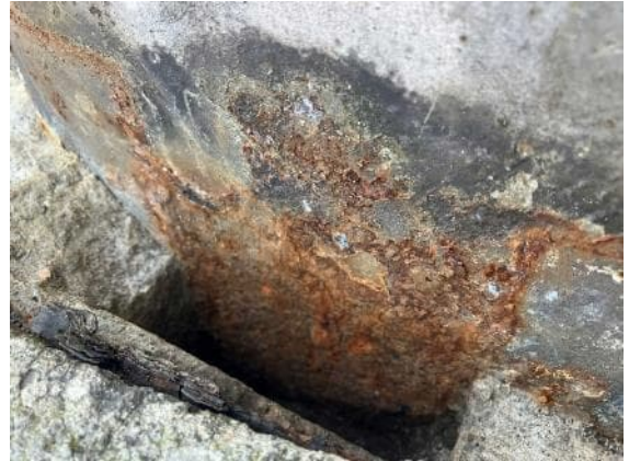
Abbildung 59: deutliche Korrosionsspuren im Bereich eines ausgestemten Holzkeils Mast 1
