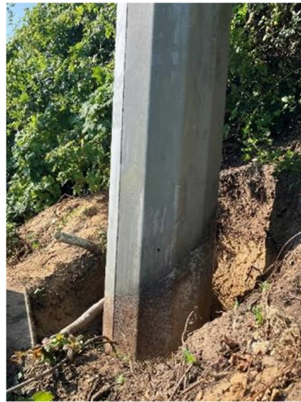
Abbildung 81: Korrosion am Mast im Bereich der Erdüberschüttung
