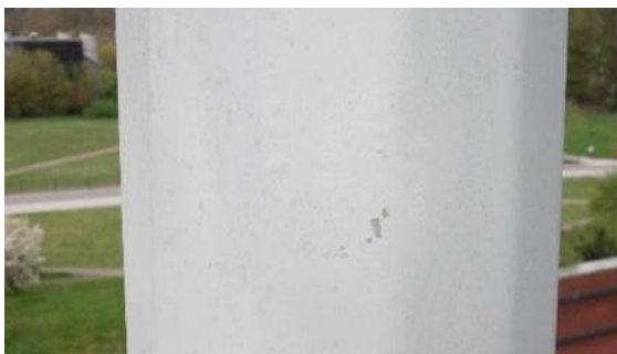
Abbildung 39: kleinere Abplatzungen an der Beschichtung
