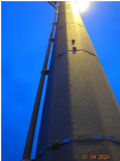
Abbildung 85: Blehbänder als Schellen über gesamte Masthöhe vorhanden
