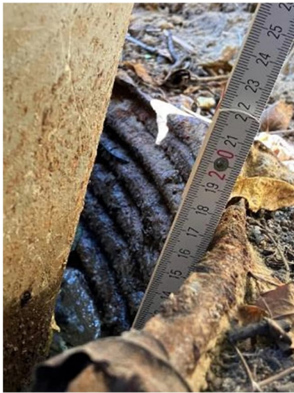
Abbildung 80: Tiefe nicht verfüllter Bereich im Köcher Mast 2
