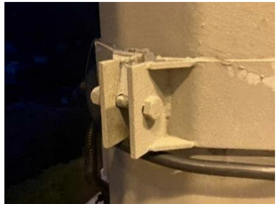
Abbildung 94: fehlende Unterlegscheibe an Befestigung der CrNi-Stahlkonsole
