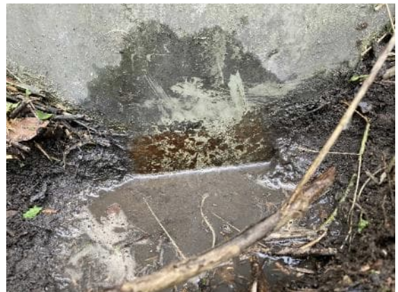
Abbildung 73: Korrosion an Mastfuß nach Freilegen von Erdreich erkennbar
