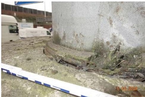
Abbildung 52: Fuge im Übergang zum Mast geschädigt und mit Holzeinschlüssen
