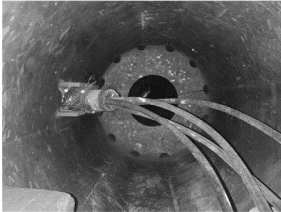
Abbildung 14: Verzinkung innen (ab 1,5 m Masthöhe nach unten) intakt
