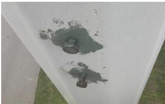
Abbildung 8: Schraube nachträglich beschichtet
