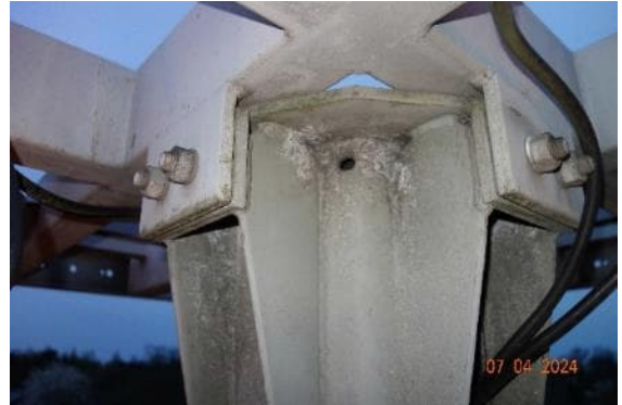
Abbildung 75: Schraubverbindung mit leichten Korrosionsspuren
