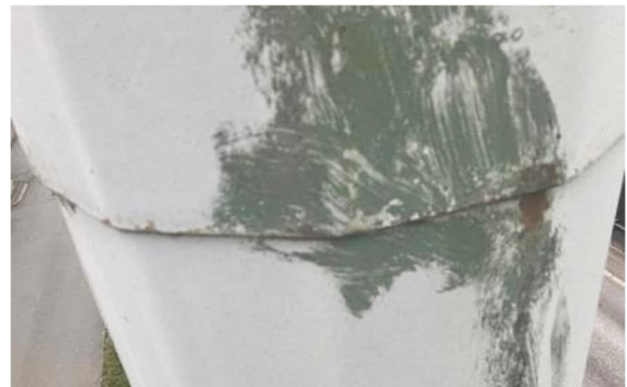
Abbildung 7: Ausbesserung der Beschichtung im Übergangsbereich der zwei Mastteile
