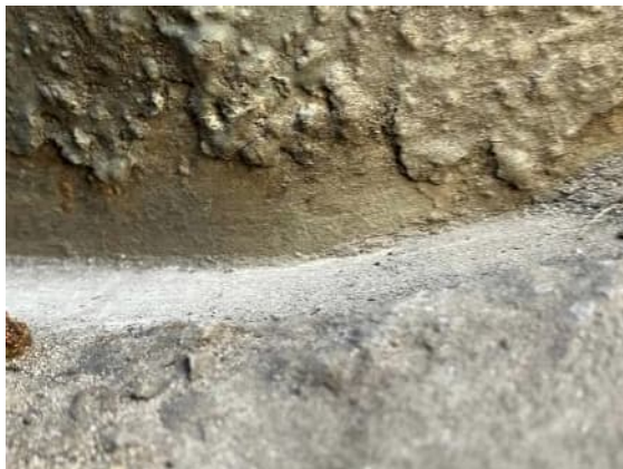
Abbildung 105: Ablösung der Beschichtung Mast 4
