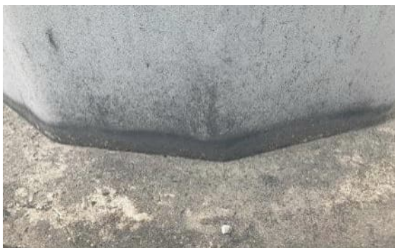
Abbildung 10: Verfärbungen am Mastfuß im Übergang zum Betonfundament, vereinzelt Korrosionsspuren
