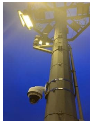
Abbildung 90: Anbau von Kameratechnik mit Blehbändern (unten) und CrNi-Stahlkonsole (oben)
