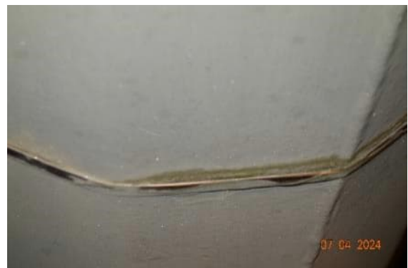
Abbildung 88: Fehlstellen in Beschichtung hinter Blehbändern ausgeführt
