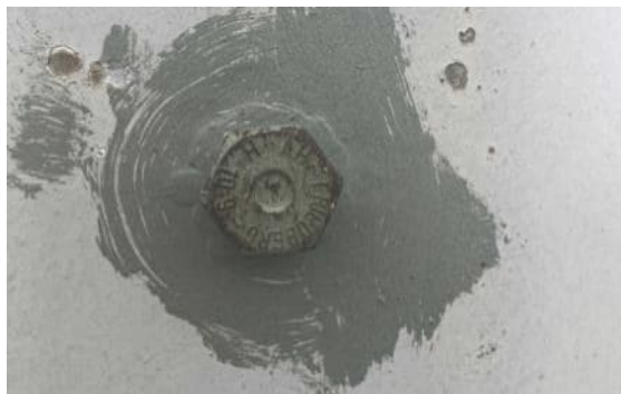
Abbildung 9: Schraube nachträglich beschichtet
