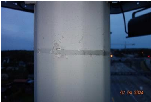
Abbildung 64: Farbunterschiede und Abplatzungen der Beschichtung im Bereich ehemals angebrachter Blehbänder o.Ä.
