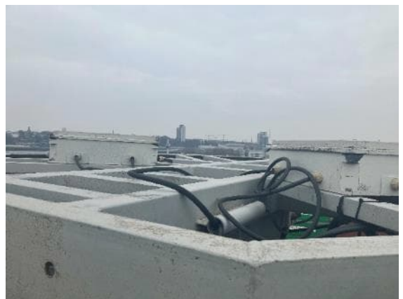
Abbildung 21: Abrasion der Beschichtung, keine Korrosion festgestellt
