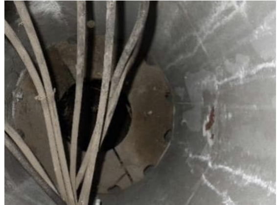
Abbildung 92: Korrosion an der Mastinnenseite am Mastfuß
