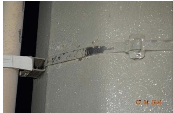
Abbildung 84: Beschichtung über Blechbänder hinweg ausgeführt
