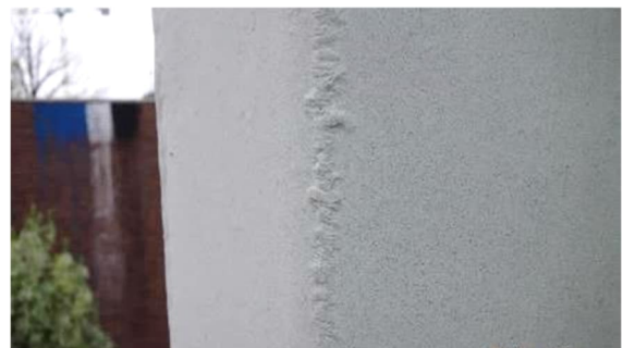
Abbildung 40: Unebenheiten an Mastoberfläche
