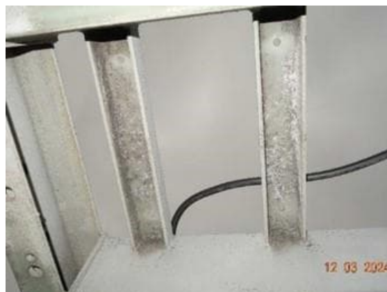
Abbildung 23: Weißrost / Zinkkorrosion an Podestunterseite
