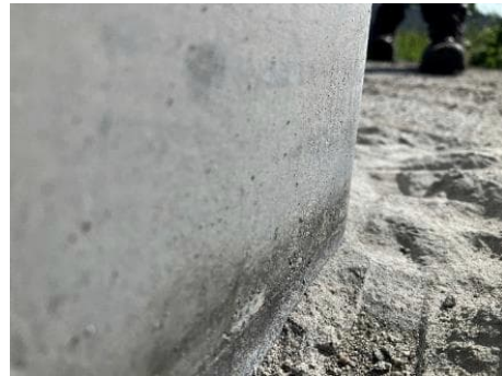
Abbildung 36: Dunkle Färbung des Masts oberhalb der Masteinbindung Mast 4A
