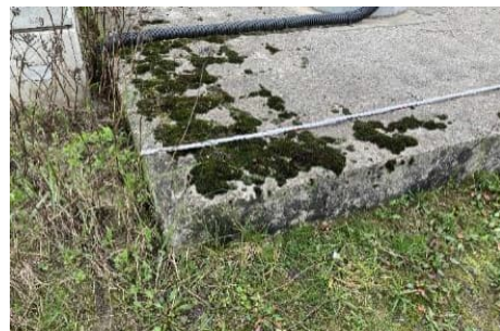
Abbildung 34: Bewuchs am Fundament Mast 4A
