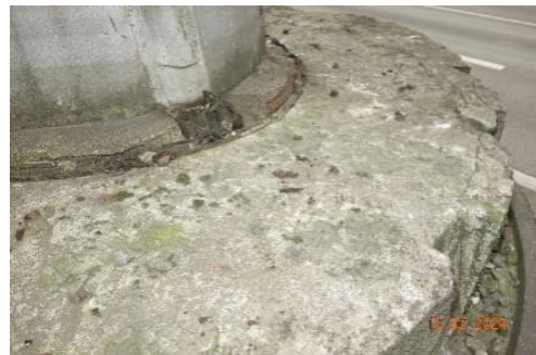
Abbildung 53: Abplatzungen und Risse an Fundamentoberseite
