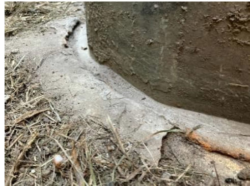
Abbildung 104: vollständiger Verguss des Köchers mit korrodierter Oberkante der Schalung Mast 4
