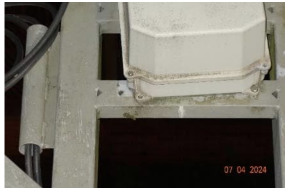
Abbildung 98: fehlende Schraube an Schaltkasten
