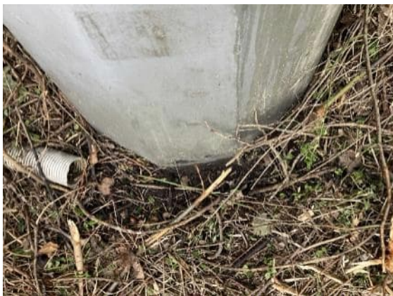
Abbildung 72: Mastfuß, Fundament nicht einsehbar, Mast mit Kontakt zu Erdreich
